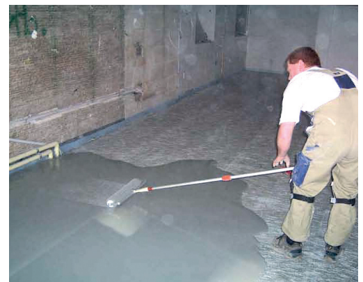
Der auf die lose verlegten Armierungsmatten geschüttete Dünnestrichmörtel wird mit dem Stachelroller sorgfältig entlüftet und mit weiterer Schüttung auf das erforderliche Niveau überspachtelt.
