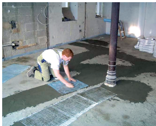
Verfüllte Kanäle und Schwachstellen in der Bodenplatte werden mit gerichteten Glasfaserarmierungssträngen quer überbrückt. Auf der getrockneten Grundierung werden Glasfaserarmmatten leicht überlappend ohne Fixierung ausgelegt.
